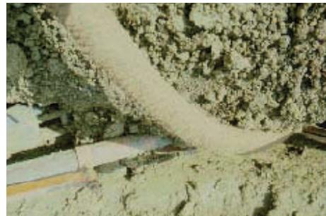
Figure 23. Excavation et mise en terre des tubes de drainage.
