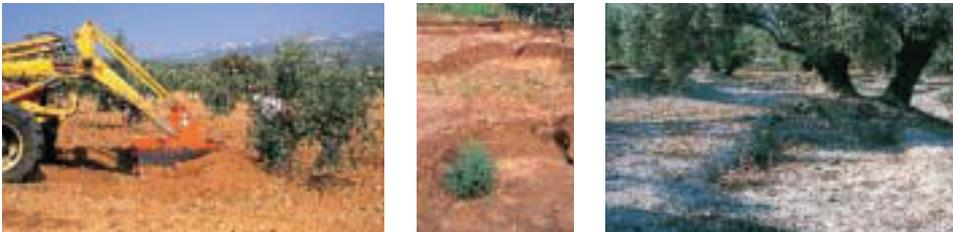
Figure 28 A) Machine utilisée pour construire des mares de petites dimensions, B) mares construites sur un sol sableux, qui ne se sont pas consolidées et se sont cassées facilement, C) mares de grandes dimensions parfaitement consolidées.
