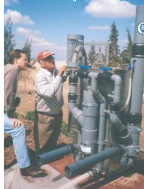
Montage du SAG dans une ferme de la région d'Agadir
